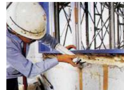
●サッシ周りに充填。ヤセ・クラックからの結露や漏水を防ぎ、断熱・防水を確保。
