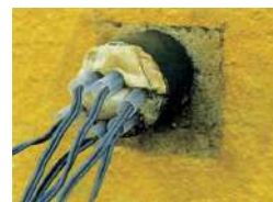
●各種設備配管の空隙に充填。シール効果万全。
