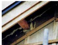
●スタイロフォームの目地に充填・機密・断熱効果を大幅向上。
